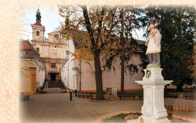
Pred kostolom na mieste bývalého panského rybníka sa v súčasnosti nachádza verejný park so zreštaurovanou sochou sv. Jána Nepomuckého. Park nesie meno Štefana Rausa (1880-1958). Bývalý ilavský učiteľ, starosta, kronikár bol aj organistom v kostole a viedol spevácky zbor. In front of the church, on the site of a former manorial pond nowadays there is a public park with a restored statue of St. John of Nepomuk. The park is named after Stefan Raus (1880-1958) the former Ilava teacher, chronicler, organist in the church, and choir director.
